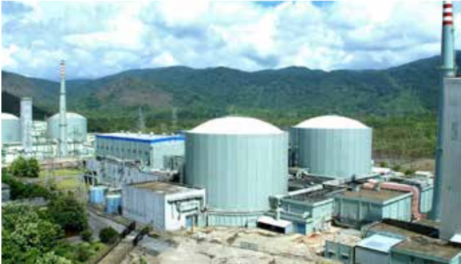
बीएचईएल निर्मित टर्बाइन-जेनरेटर सेट से लैस एनपीसीआईएल कैगा
