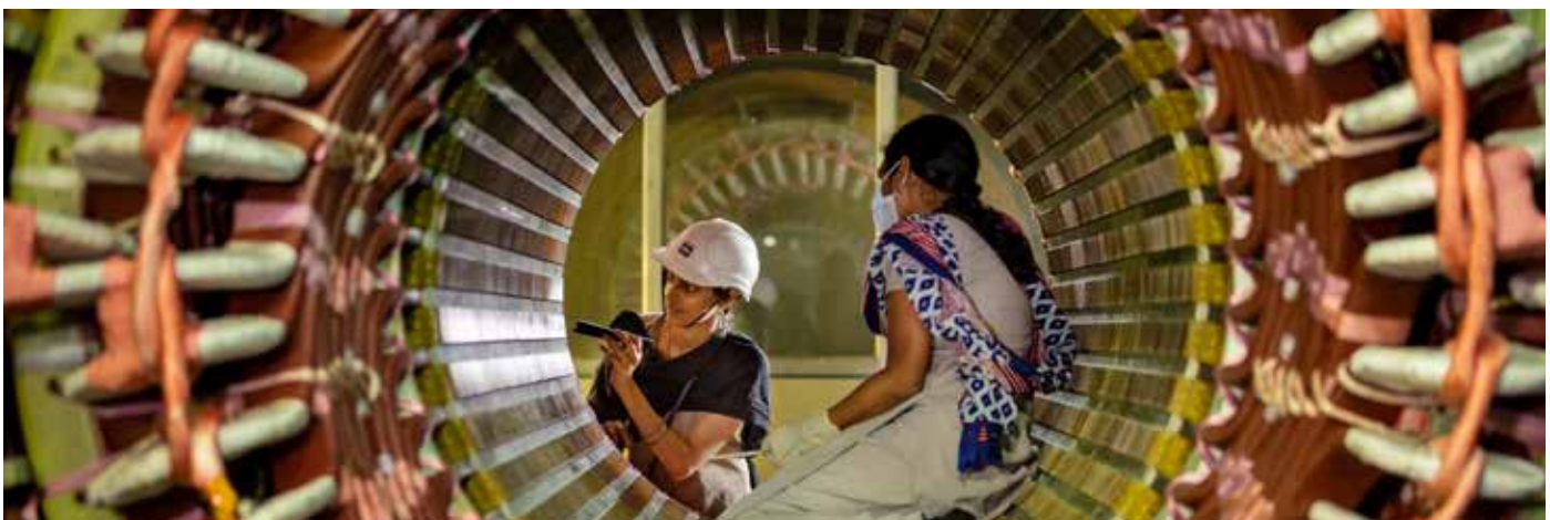
एचपीईपी, हैदराबाद में जनरेटर स्टेटर का निरीक्षण करते इंजीनियर
