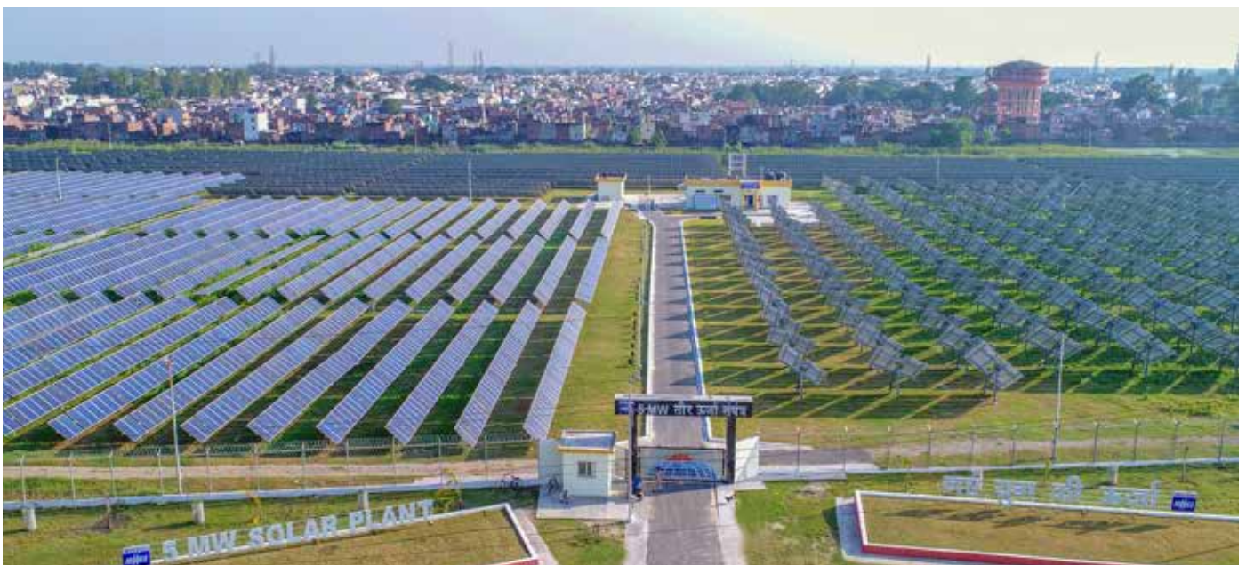
बीएचईएल द्वारा निर्मित हरिद्वार प्लांट परिसर में 5 मेगावाट सौर ऊर्जा संयंत्र, जमीन पर लगाई गई मोटर ट्रेकिंग और निष्क्रिय ट्रेकिंग मॉड्यूल
