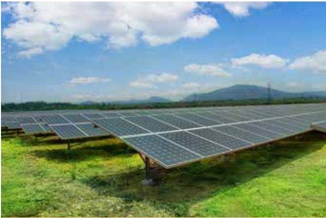
बीएचईएल रानीपेट में बीएचईएल के 5 मेगावाट सोलर पीवी का जमीन पर संस्थापन
