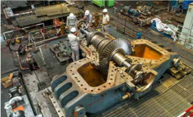
बीएचईएल हैदराबाद में कैप्टिव पावर प्लांट के लिए 150 मे.वा.स्टीम टरबाइन पर चल रहा कार्य
