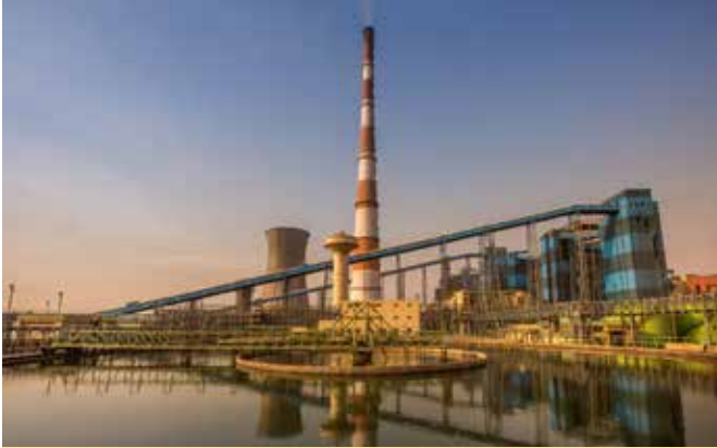
बेल्लारी टीपीएस में क्लैरिफ्लोकुलेटर । बीएचईएल पावर प्लांटों के लिए जल संबंधी संपूर्ण समाधान प्रदान करता है।
