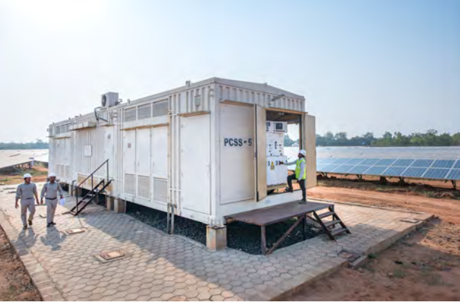
बीएचईएल द्वारा नयवेली तमिलनाडु में स्थापित 65 मेगावाट एसपीवी संयंत्र के साथ एकीकृत बैटरी एनर्जी स्टोरेज सिस्टम (बीईएसएस)
